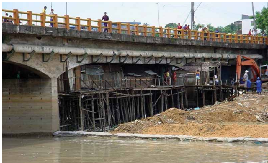
Demolição das palafitas debaixo da ponte às margens do igarapé do 40
