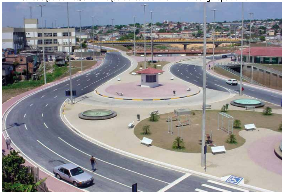
FIGURA 20 Construção de vias, urbanização e áreas de lazer na foz do igarapé do 40
