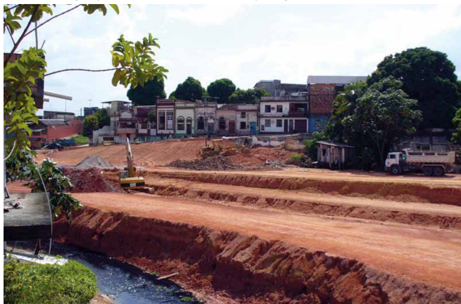
FIGURA 17 Foz do igarapé Bittencourt e obras de terraplenagem
