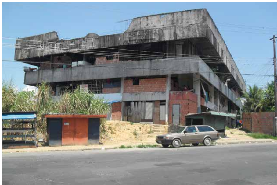
FIGURA 3 Prédio invadido na Praça 14 em Manaus (jul. 2010)
