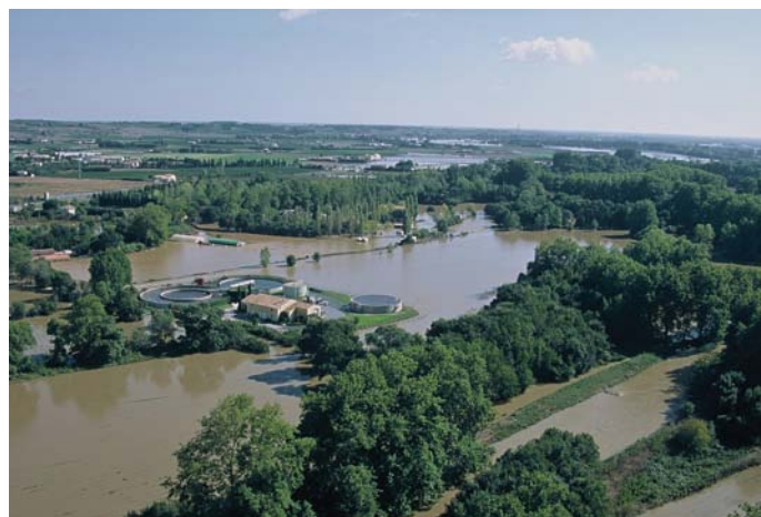
Obr. 6b. Povodeň v létě 2005 v centrální části povodí. Ušetřena byla pouze čistírna odpadních vod postavená na navýšené plošině. Zdroj DDE30
