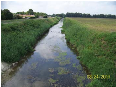
Obr. 4a. Regulované koryto řeky Vistre v blízkosti Nimes. Řeka v létě trpí eutrofizací, teplota vody dosahuje 25 °C. Kvůli značnému zahloubení a prudkým břehům chybí břehová vegetace. Levý břeh je navíc lemován protipovodňovou hrází
